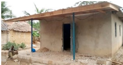
La salle d'assemblée à La Mé, en Côte d'Ivoire – en cours de réparation.
